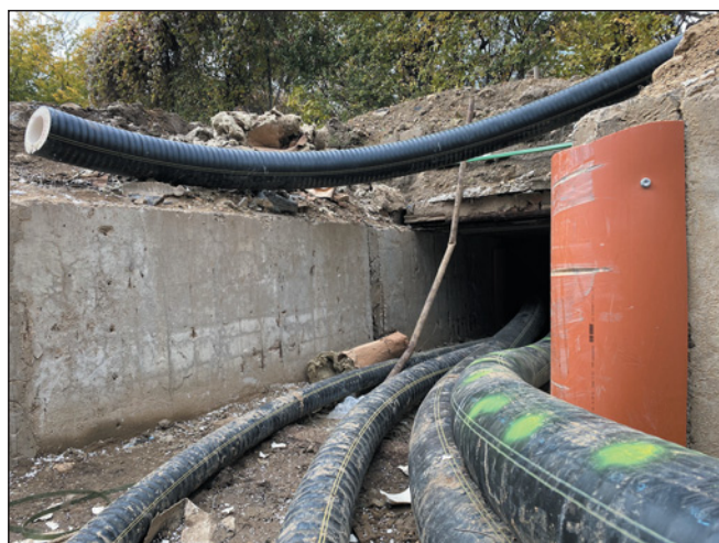
▼ Obr. 9 ● Viditelný poloměr ohybu potrubí d160/DA225 a dočasná ochrana rohů kanálu před poškozením při vtahování flexibilních kotočů
