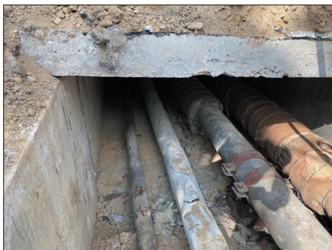
▼ Obr. 8 ● Původní kanál při odstraňování izolace, viditelné konzoly potrubí
