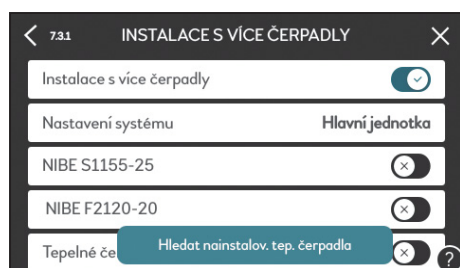
◀ Obr. 3 ● Ukázka displeje tepelného čerpadla S1155 a konfigurace kaskády
