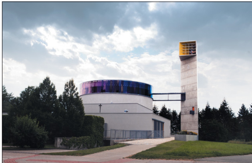
▲ Kostel blahoslovené Marie Restituty, využívá pro vytápění a chlazení tepelné čerpadlo země-voda IVT GEO G s výkonem 80 kW
