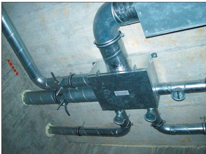
▲ Obr. 1 ● Detail prostupu potrubí stěnou a upevnění rozdělovací komory
