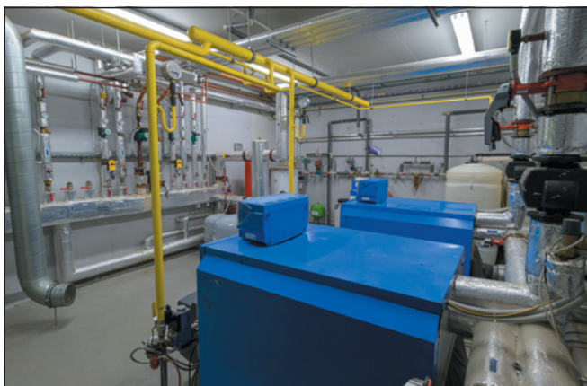
▲ Obr. 6 ● Plynová kotelna, foto: Petr Hamerník, ZOO Praha
