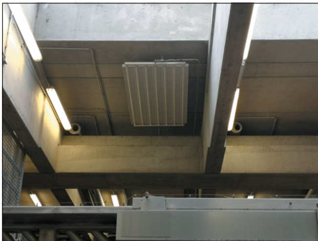
▲ Obr. 2 ● Stropní sálavé pásy, foto: autor
