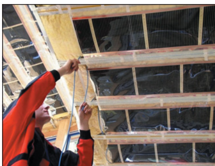
▼ Obr. 4 ● Montáž prvků stropního vytápění Fenix
