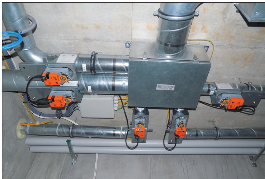
▲ Obr. 4 ● Umístění servopohonů
