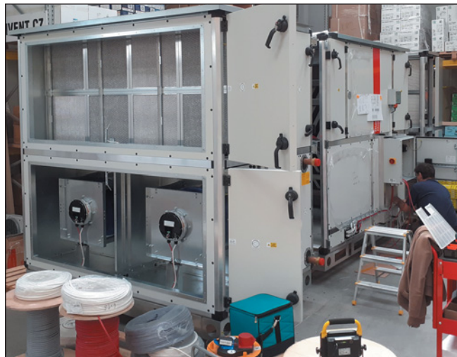
▲ Obr. 11 ● Montáž jednotek DUOVENT® MODULAR ve výrobním závodu ELEKTRODESIGN ventilátory, s.r.o.
