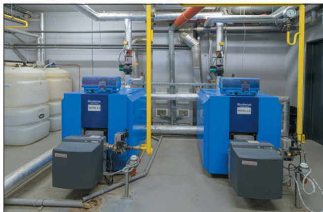
▲ Obr. 7 ● Kotle Buderus Logano GE315 a nádrže na topný olej, foto: Petr Hamerník, ZOO Praha
