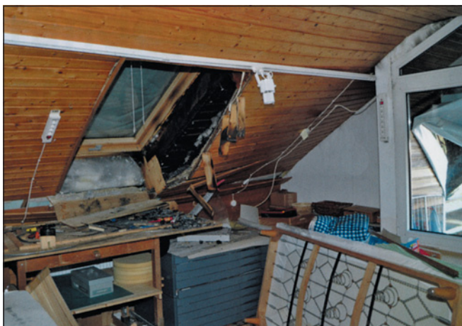
▲ Obr. 3 ● Pohled do podkrovního ateliéru. Na bočním ostění střešního okna byly zaznamenány první plamínky. Po sejmutí palubkového obkladu ostění je patrné, že požár v této místnosti nevznikl, ale pokud by nedošlo ke včasnému zásahu hasičů, tak by se do ní rozšířil
