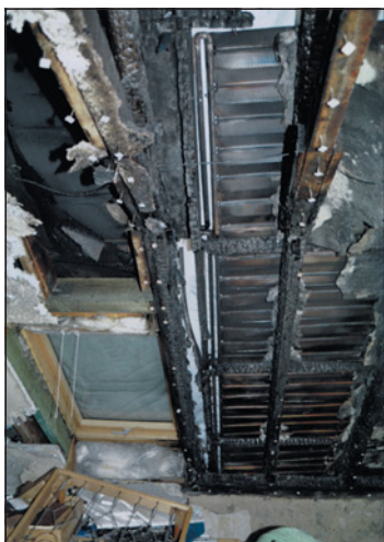
▲ Obr. 3 ● Pohled do podkrovního ateliéru. Na bočním ostění střešního okna byly zaznamenány první plamínky. Po sejmutí palubkového obkladu ostění je patrné, že požár v této místnosti nevznikl, ale pokud by nedošlo ke včasnému zásahu hasičů, tak by se do ní rozšířil
