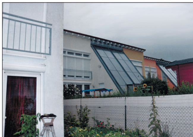
▲ Obr. 5 ● Pohled na část dvojdomu s přístavbou pro příslušenství solární soustavy plně krytou kolektory
