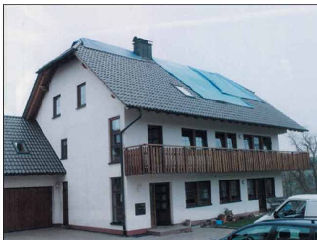
▲ Obr. 1 ● Pohled na požárem zasažený dvougenerační rodinný dům, pod plachtou se nacházejí požárem poškozené solární kolektory a část střechy
