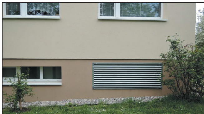
▲ Obr. 4 ● Nasávání a výfuk tepelných čerpadel na fasádě Renoirova 622/5, Praha 5
