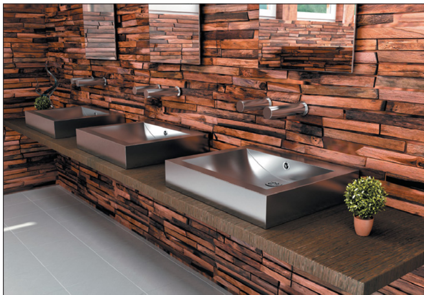
▲ Instalace centrálního dávkovače mýdla SLZN 83E3 a umyvadlových baterií SLU 43B
