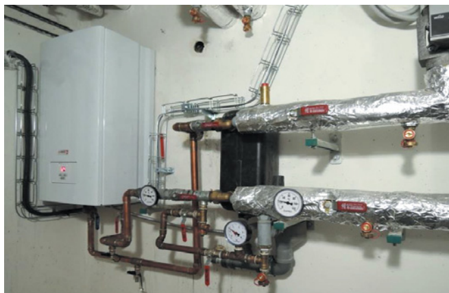
▲ Obr. 7 ● Elektrický kotel
