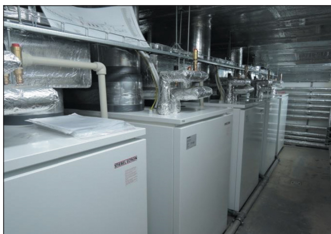
◀ Obr. 5 ● Tepelná čerpadla WPL 23
