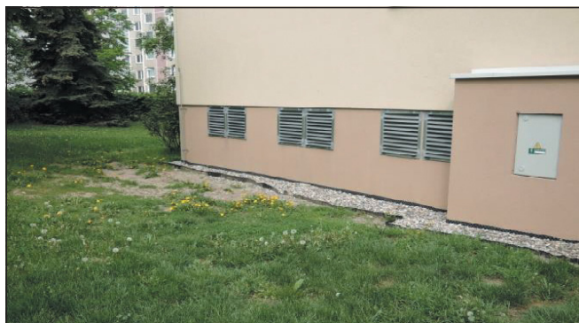
▲ Obr. 4 ● Nasávání a výfuk tepelných čerpadel na fasádě Renoirova 622/5, Praha 5
