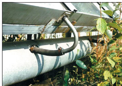
▲ Obr. 7 ● Přívod do celohliníkového kolektoru pomocí olejové hadice
