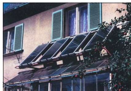
▼ Obr. 12 ● Kolektory s měděným absorberem v ocelovém rámu, vhodně použité s gravitačním oběhem
