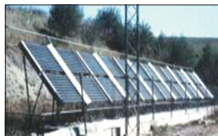
▲ Obr. 23 ● Realizací 280 trubic, 56 m 2 , JRD Suchá Hora, skončila tato nadějná cesta
