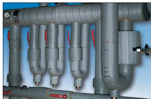
▼ Obr. 20 ● Izolace velkých celků
