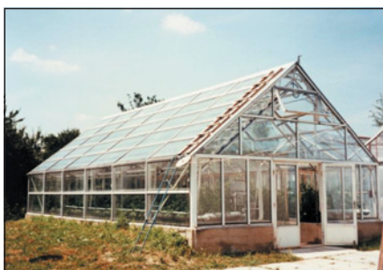
▲ Obr. 25 ● Fresnelovy čočky na jižní střeše skleníku, Třeboň
