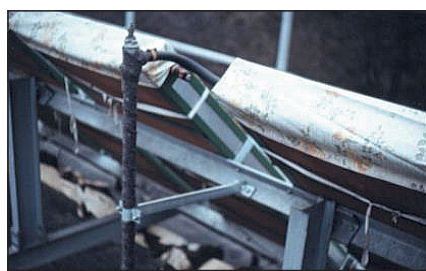
▲ Obr. 8 ● Když nebyla ještě vyvinuta nemrznoucí kapalina, kolektory se na zimu zabalily proti působení počasí do obalu
