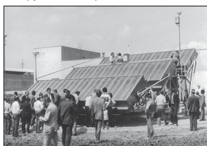
▼ Obr. 20 ● Ploché koncentrační kolektory automaticky natáčené za Sluncem, Chropyně (v ČSSR pouze 2 realizace)
