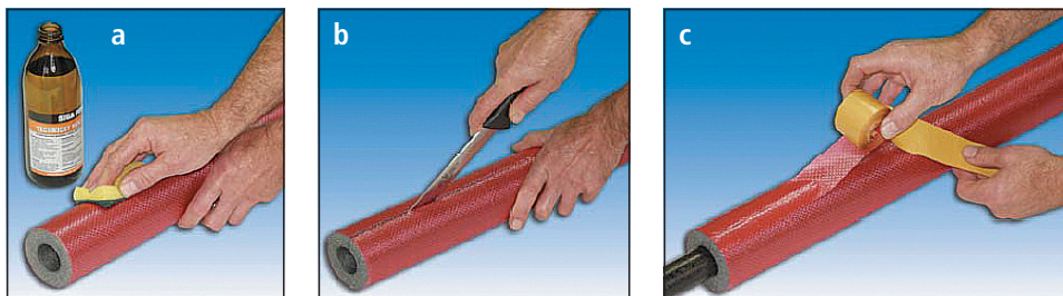
▲ Obr. 7 ● Postup izolace potrubí
