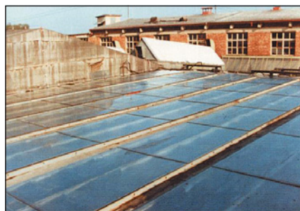
▲ Obr. 18 ● Svařené a zasklené fóliové rukávce z PE, kterými protékala voda shora dolů gravitačně
