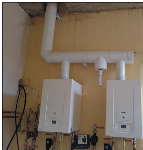
▲ Obr. 5 ● Kaskáda typu OFFSET
