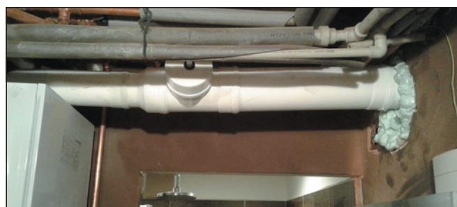
▲ Obr. 3 ● Nesprávné použití redukce
