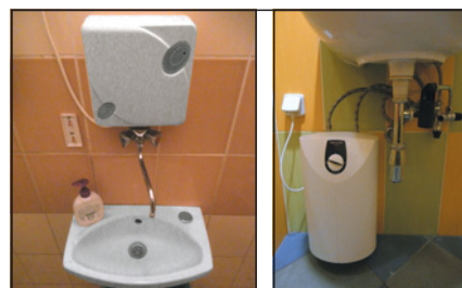
▲ Obr. 2 ● Ohřivač vody průtokový (vlevo), zásobníkový (vpravo)
