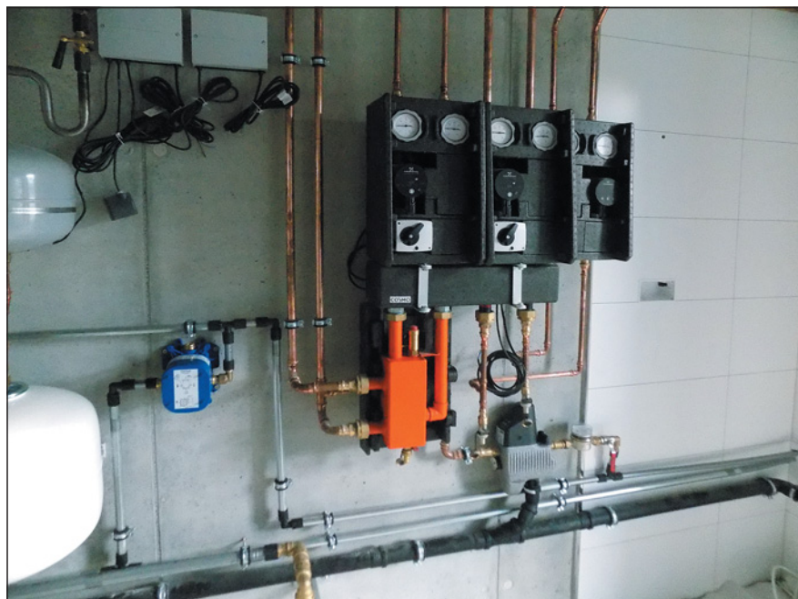
▼ Obr. 1 ● Čerpadlové skupiny od firmy Meibes
