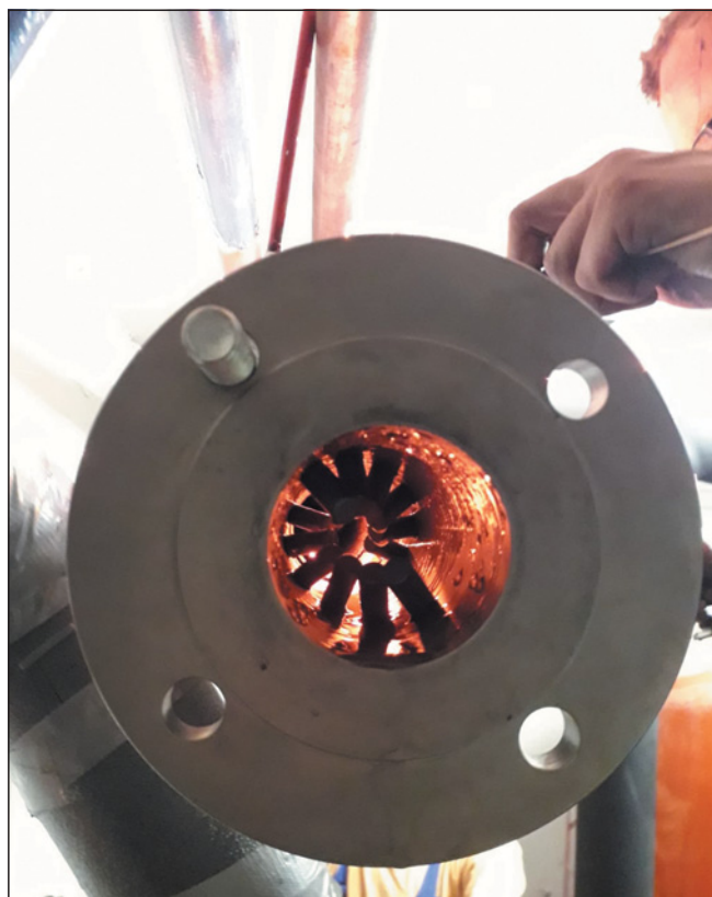
▼ Obr. 2 ● Sametová, Liberec – detail na svařování příruby
