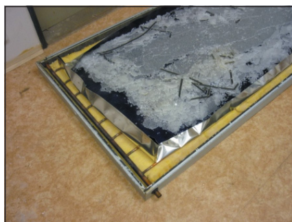
Obr. 1 Průběh rozebírání solárních kolektorů
