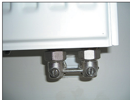
Obr. 1 Při realizaci bylo použito kompaktní radiátorové šroubení od firmy MEIBES
