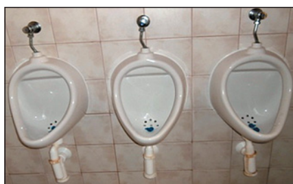
Obr. 11 Nečistoty na těle zápachové uzávěrky způsobené povolenou převlečnou maticí
