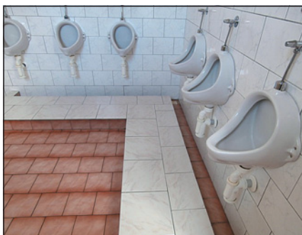
Obr. 4 Nebezpečný schod u pisoáru
