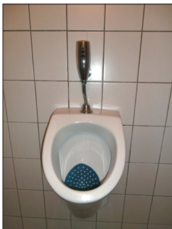
Obr. 6 Vyosený splachovač pisoáru
