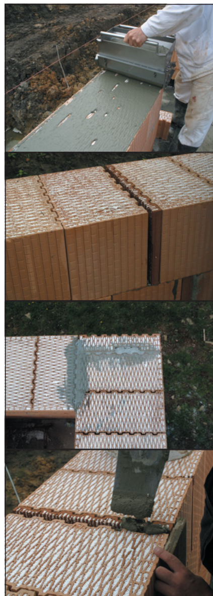
Obr. 7 Příklad použití – pro zdění je vhodné používat tenkovrstvé malty, popř. PUR pěnu z důvodu eliminace tepelných mostů, tepelně-izolační malta má cca 2× menší tepelnou vodivost než keramický střeš, proto nevznikají tepelné mosty
