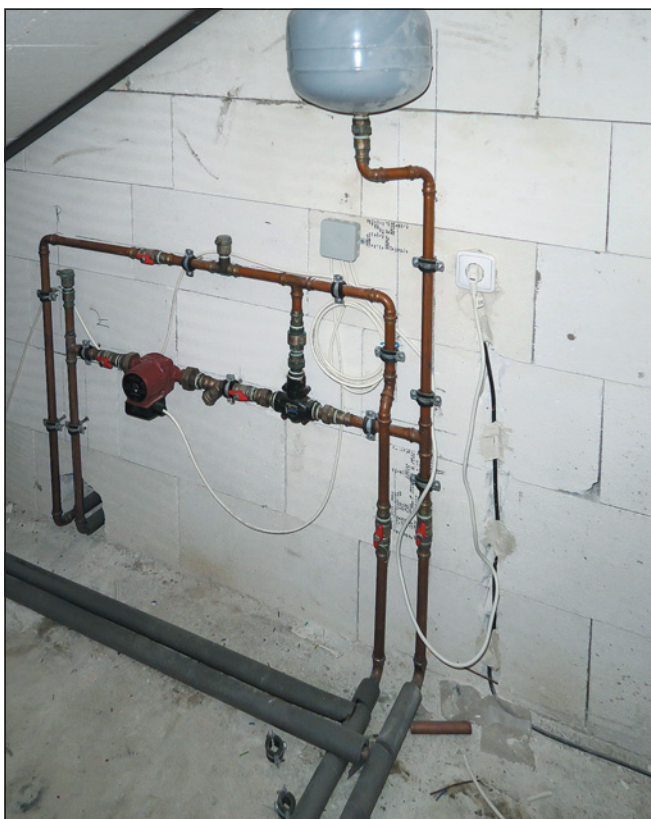
▼ Obr. 2 ● Vnitřní okruh krbové vložky s výměníkem
