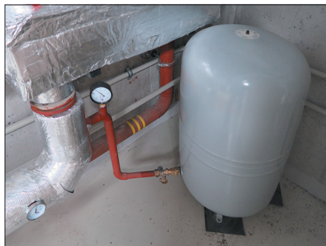
▼ Obr. 3 ● Tlaková expanze bez uzávěru a manometru za uzávěrem
