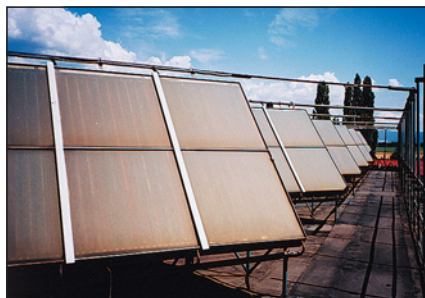
▲ Obr. 3 ● Saze na roky nemytých kolektorech zajišťovaly „přirozené stínění“
