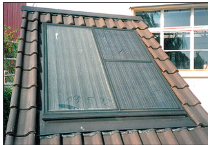
▲ Obr. 2 ● Prach výrazně snižuje výkon kolektorů – prstem napsané datum 19. 2. 92 do pylového prachu
