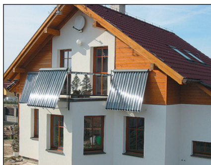
▲ Obr. 14 ● Vakuové trubice na fasádě mohou působit efektivně
