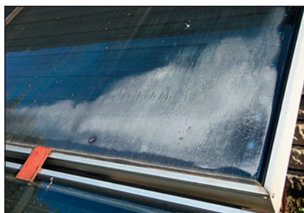
▲ Obr. 8 ● Zkondenzovaná voda na vnitřním zasklení kolektoru
