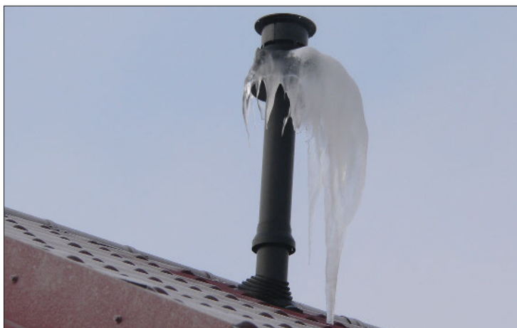
▼ Obr. 2 ● Komínová stříška na kondenzačním kotli
