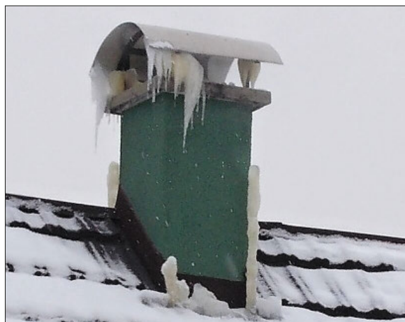
▼ Obr. 3 ● Stříška Napoleon na kondenzačním kotli
