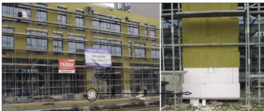
▼ Obr. 13 ● Kombinace EPS perimetru a minerální vlny (zdroj: autor)
