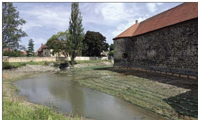
▲ Obr. 3 ● Hrad Švihov získává teplo z vodního příkopu již 25 let
