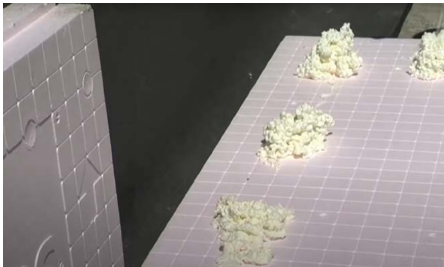
▲ Obr. 15 ● Lepení perimetru na hydroizolaci lepicí PUR pěnou (zdroj: autor)
