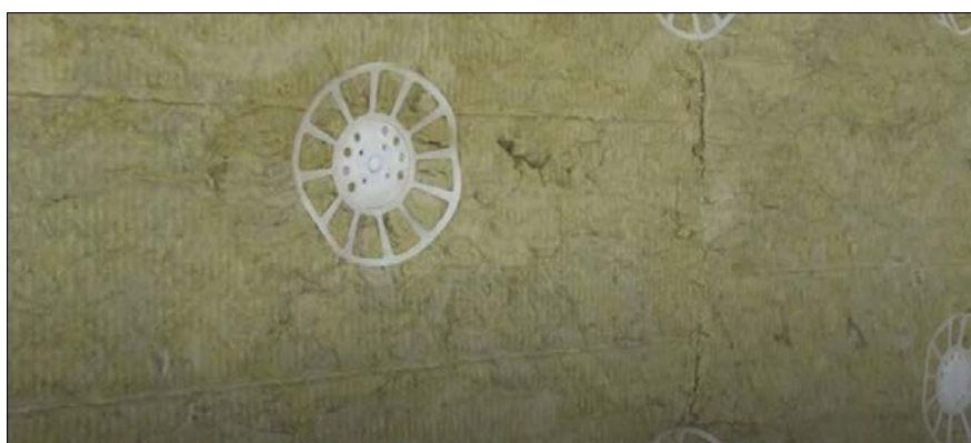
▼ Obr. 12 ● Ukotvení tepelněizolačních desek talířovými hmoždinkami (zdroj: isover.cz)
