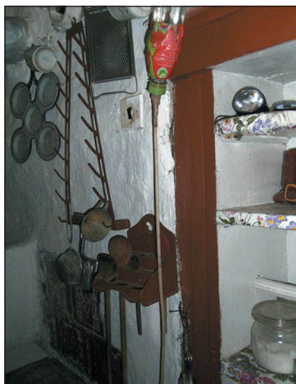
Obr. 4 Expanzní nádoba s expanzním potrubím
