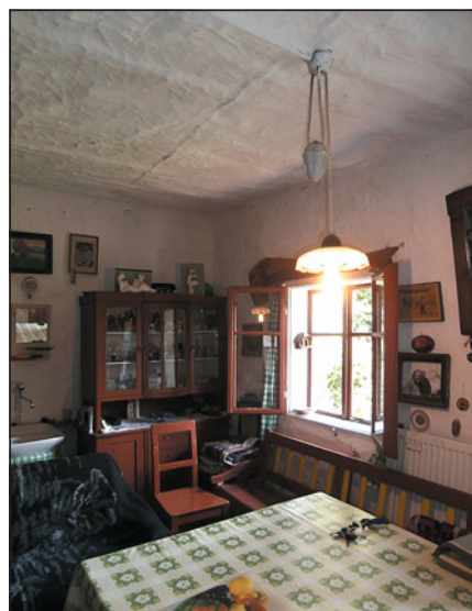
Obr. 1 Jedno z oken domu a jediné otopné těleso v domě vedle něj
