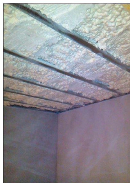
▲ Obr. 2 ● Tepelná izolace podkroví polyuretanovou pěnou zevnitř
