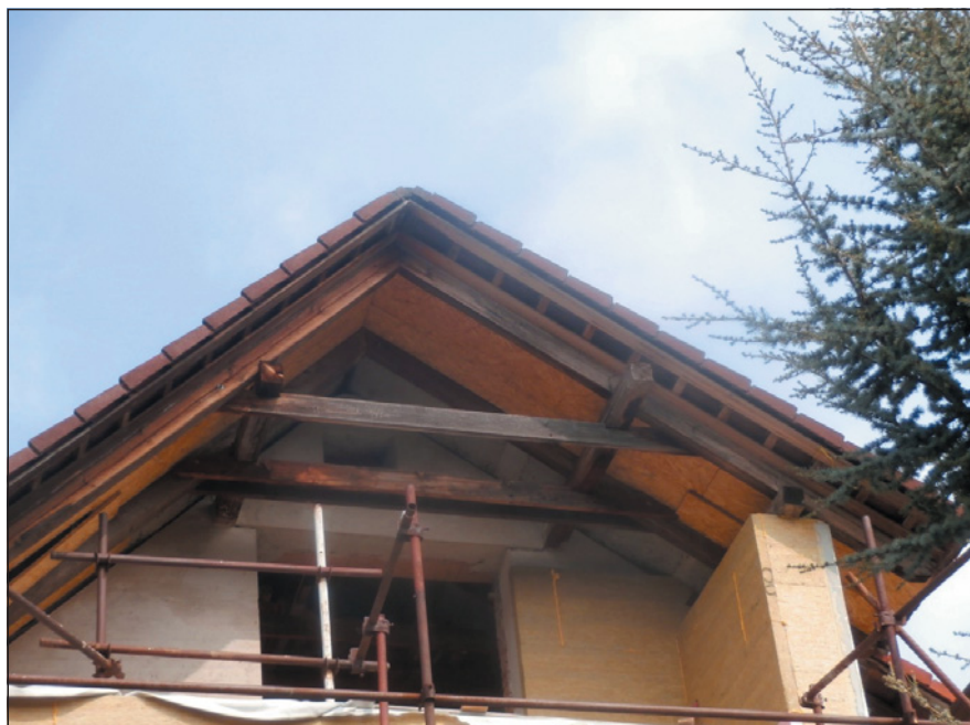
▲ Obr. 1 ● Tepelná izolace podkroví minerální vatou zvenku
