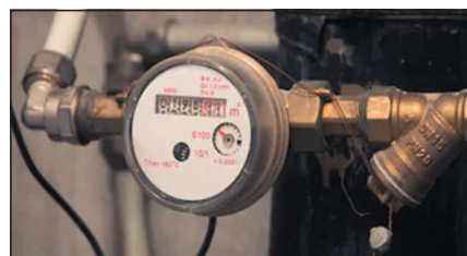
▲ Obr. 25 ● Filtr osazený před vodoměrem
