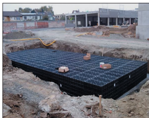
▼ Obr. 16 ● Vsakování srážkové vody; vlevo – v malém množství, vpravo – ve velkém množství
