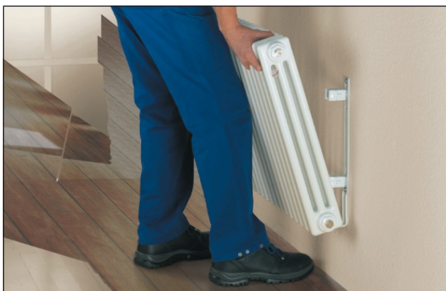
▼ Obr. 5 ● Použitím rychloupínací upevňovací sady EasyFix je montáž radiátorů Zehnder Charleston snadná a rychlá – instalatér ušetří až třetinu času na montáž
