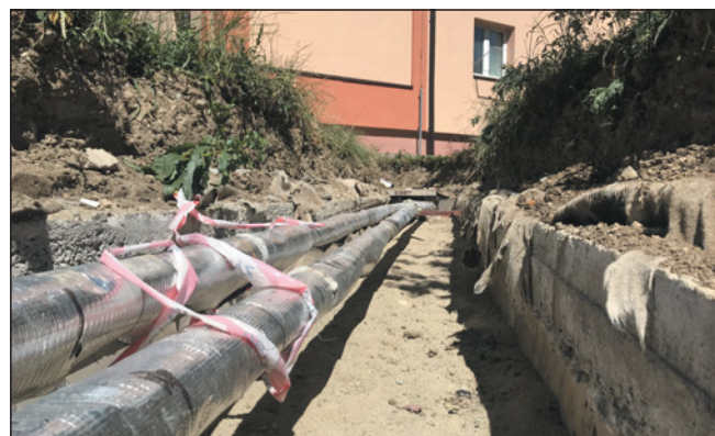
▲ Obr. 3 ● Připravený kanál pro pokládku plastového předizolovaného potrubí, zatím s původním potrubím na TV+C
