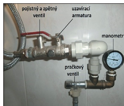
▼ Obr. 13 ● Zapojení armatur u tlakového OV
