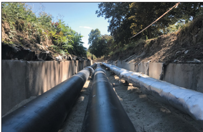
▼ Obr. 2 ● Dosluhující potrubí TV s cirkulací a už nové ocelové předizolované potrubí na hlavní trase
