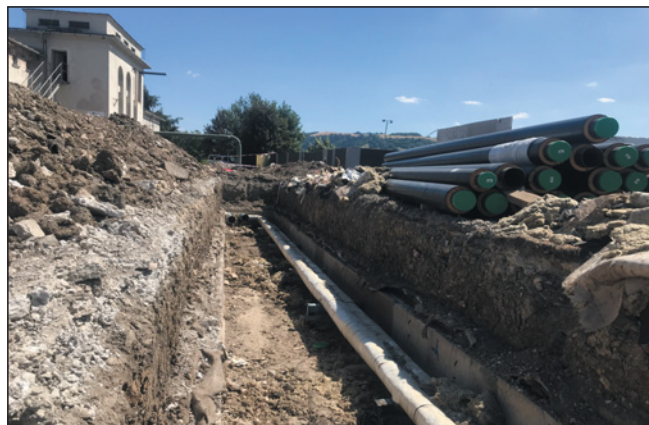
▼ Obr. 4 ● Připravený kanál na pokládku ocelového předizolovaného potrubí s pohledem na kotelnu, zatím s původním potrubím na TV+C
