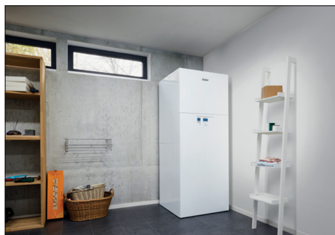
▼ Obr. 1a ● Rohová instalace tepelného čerpadla versoTHERM plus (bez jednotky versoVAIR)
