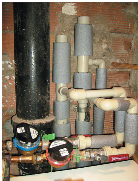
▲ Obr. 8 ● Rozvod teplé vody s cirkulací bez regulačních armatur, kdy teplá voda v okruzích vzdálenějších od ohřívače cirkuluje málo nebo necirkuluje vůbec
