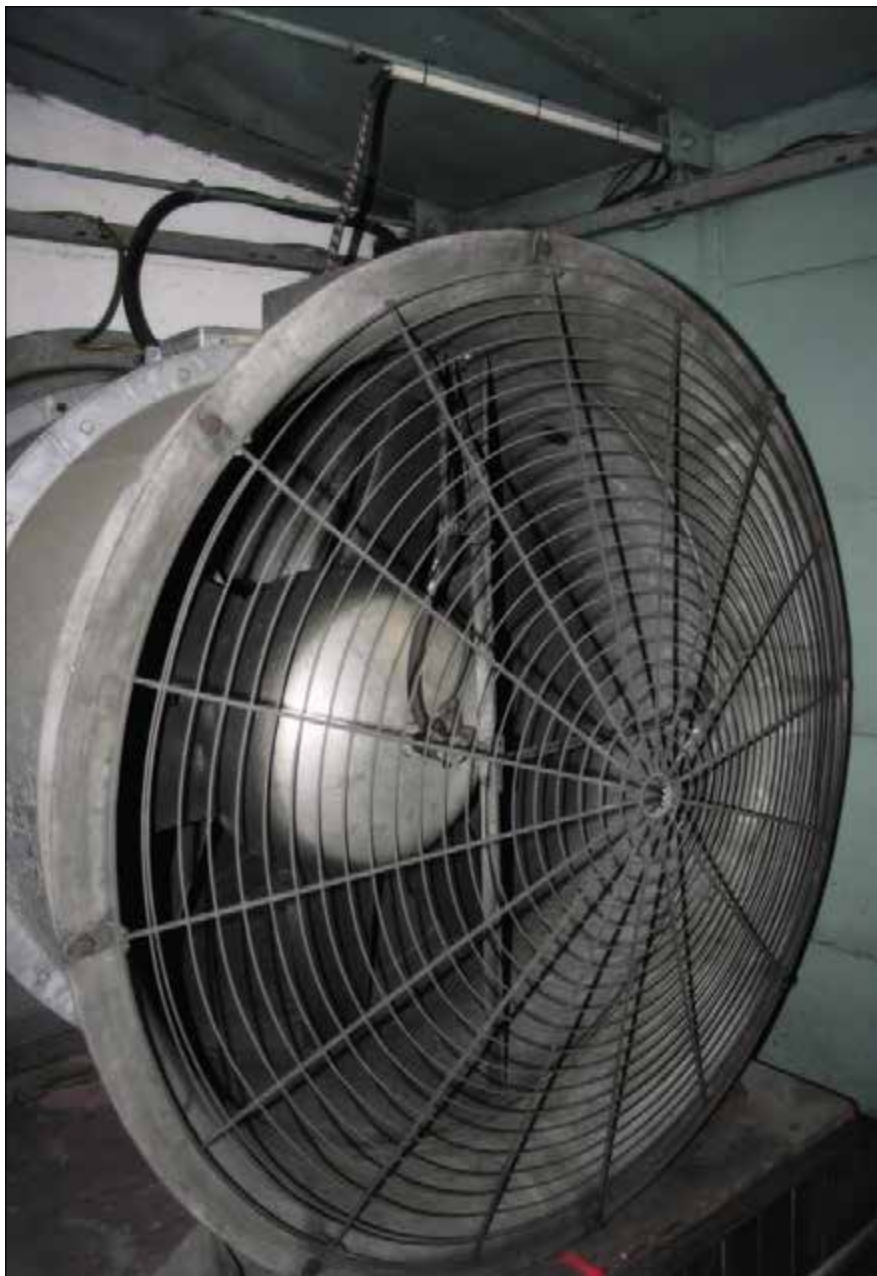
▲ Obr. 8 ● Stávající ventilátor hlavního přívodu vzduchu
