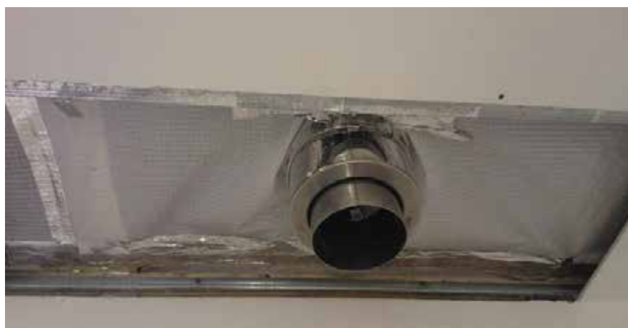
▼ Obr. 8b ● Chybné a nebezpečné provedení
