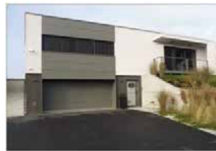
▲ Obr. 9 ● Dům po úpravách snižujících energetickou náročnost
