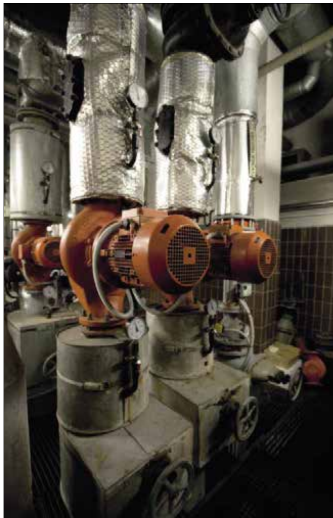
▲ Obr. 4 ● Čerpadlové skupiny topných okruhů suterénu
