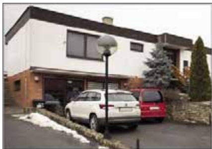
▲ Obr. 7 ● Východní a jižní část rodinného domu před zateplením
