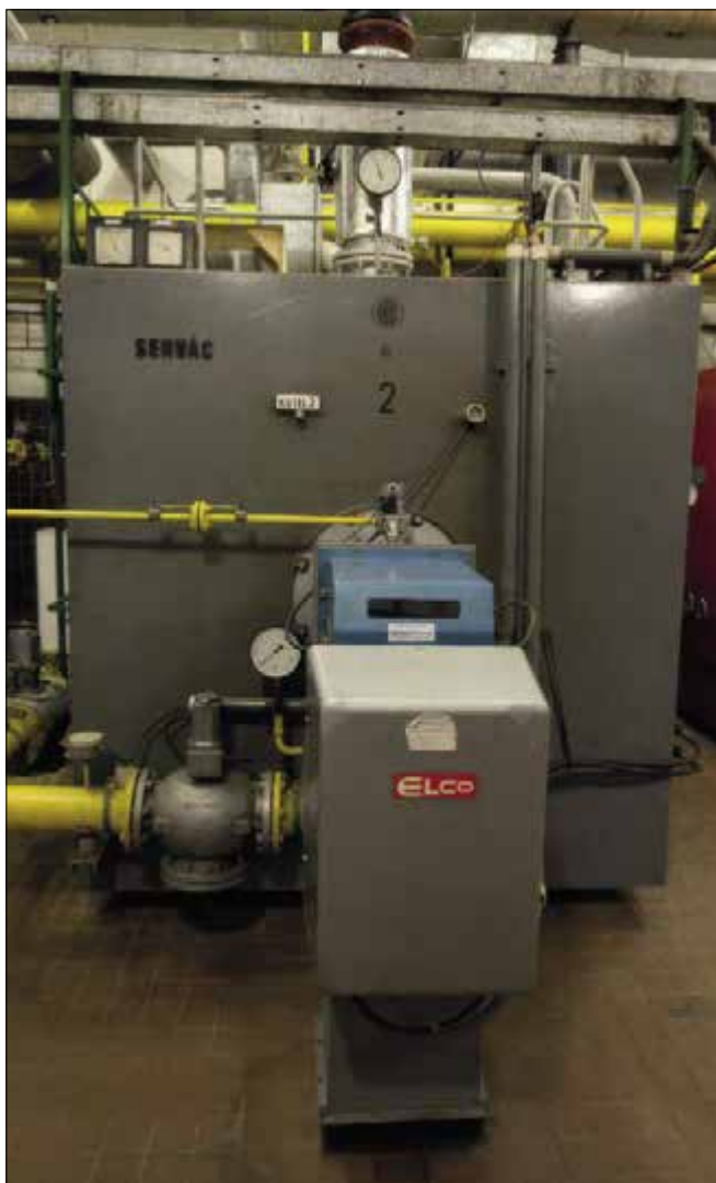
▲ Obr. 1 ● Teplovodní kotel Servác (výrobce ČKD Dukla v licenci fy Buderus), kombinovaný hořák ELCO EKLG 1400 R
