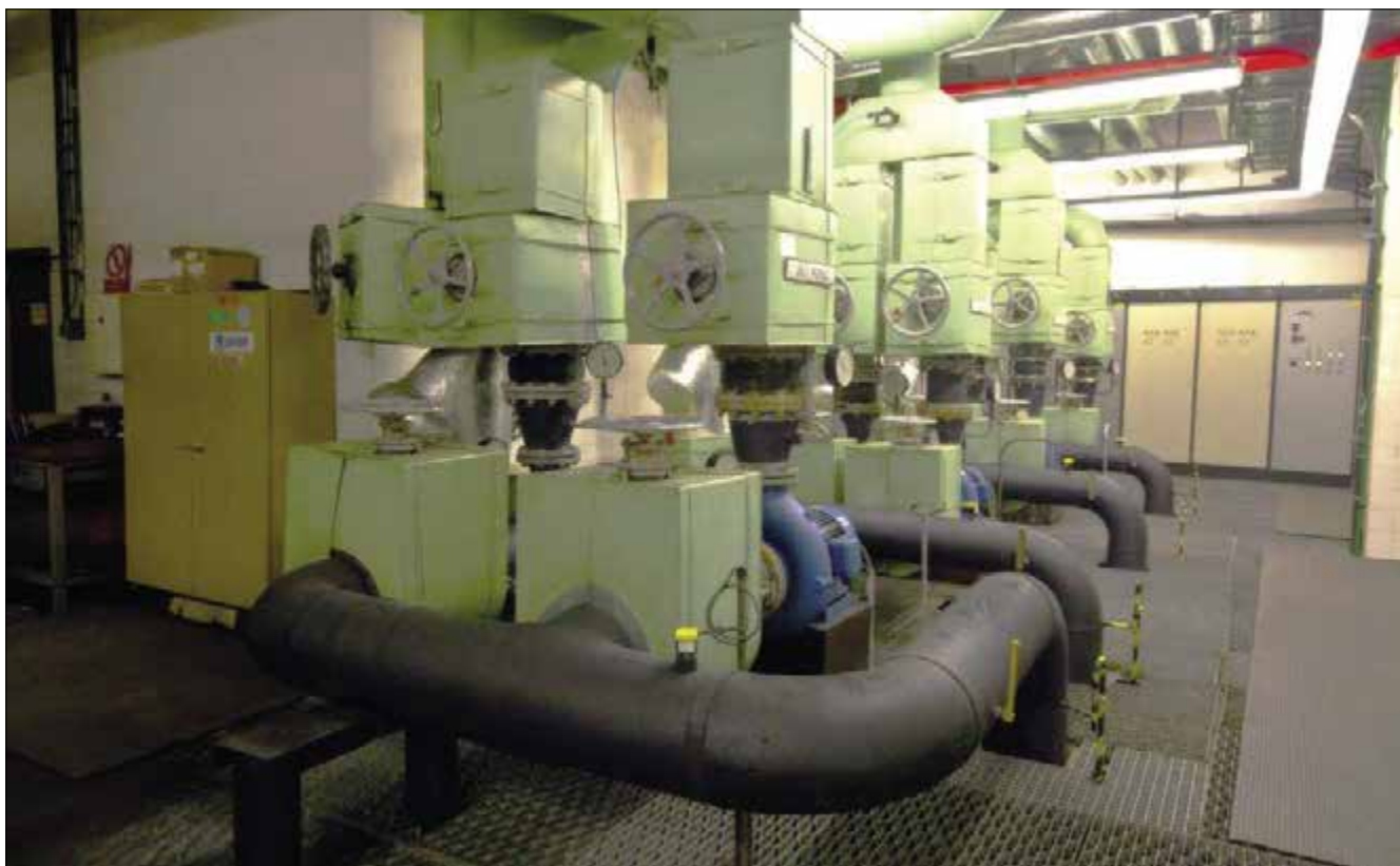
▲ Obr. 6 ● Čerpadlové skupiny okruhů chladicí vody
