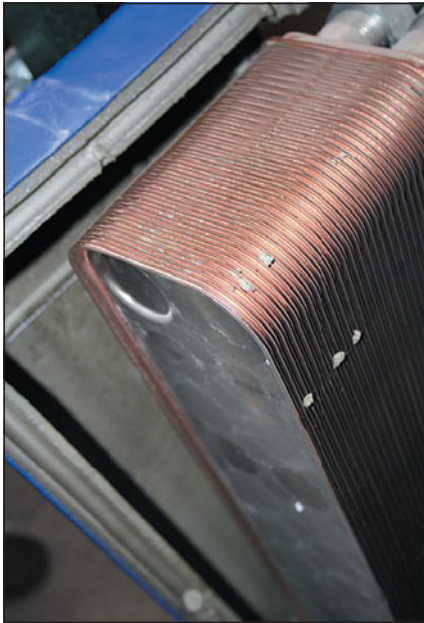
▲ Obr. 3 ● Detail ohřivače vody, nerez pájený čistou mědí
