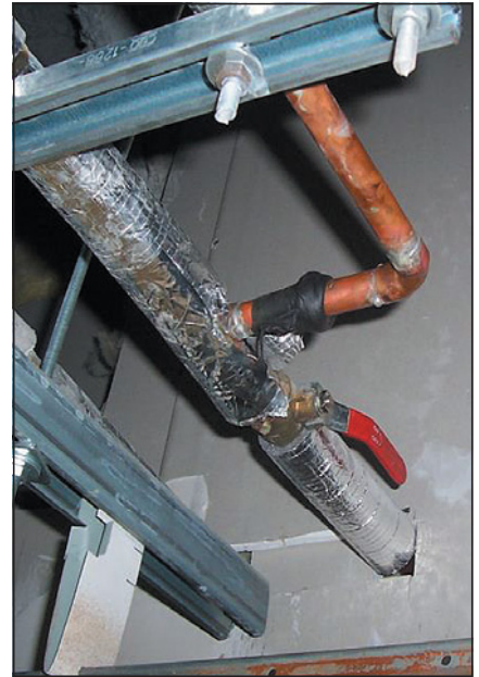
▲ Obr. 5 ● Oprava měděného potrubí
