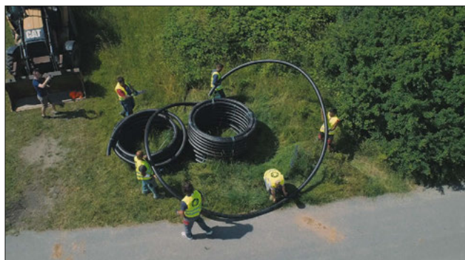
▼ Obr. 6 ● Plastové předizolované potrubí NRG FibreFlex Pro pro projekt Dukovany
