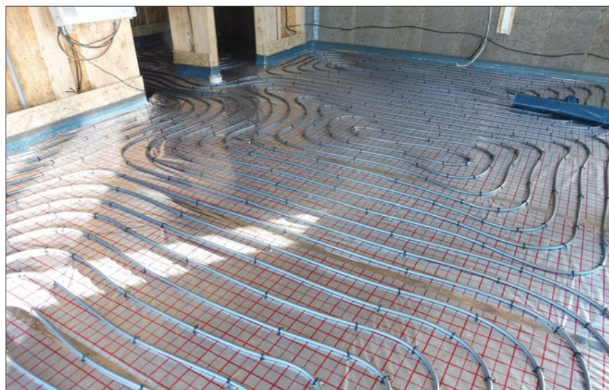
▼ Obr. 24 ● Podlaha s trubkami připravenými k zalití anhydridem (zdroj: autor)
