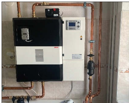
▲ Obr. 3 ● Výměnková stanice tepla PewoCompact ECO I-U1-P
