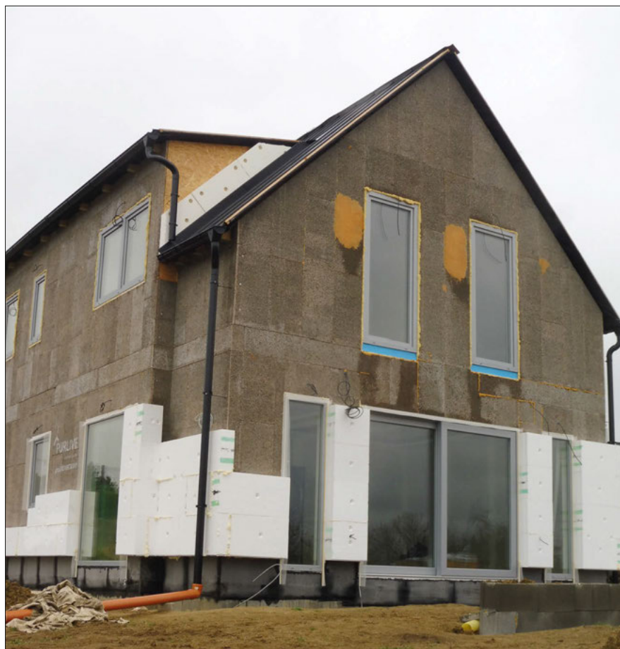
▲ Obr. 23 ● Tepelná izolace domu fasádním polystyrenem (zdroj: autor)
