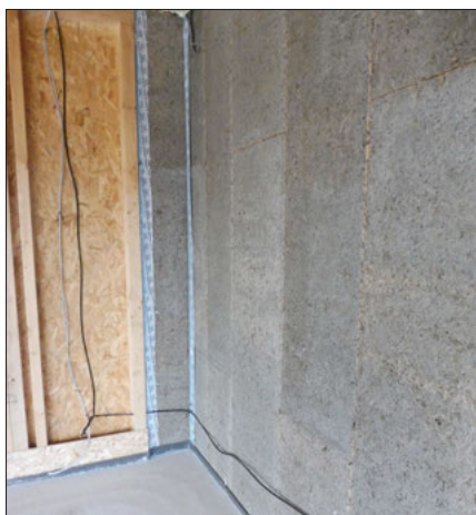
▲ Obr. 19 ● Ukázka jedné stěny zakryté (zaizolované) a druhé připravené pro izolaci (zdroj: autor)
