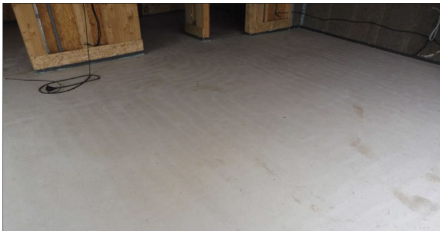
▲ Obr. 25 ● Trubkové hady zalité anhydridovou vrstvou (zdroj: autor)
