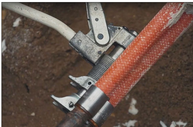
▼ Obr. 7 ● Ukázka lisování při dvoutrubkovém systému
