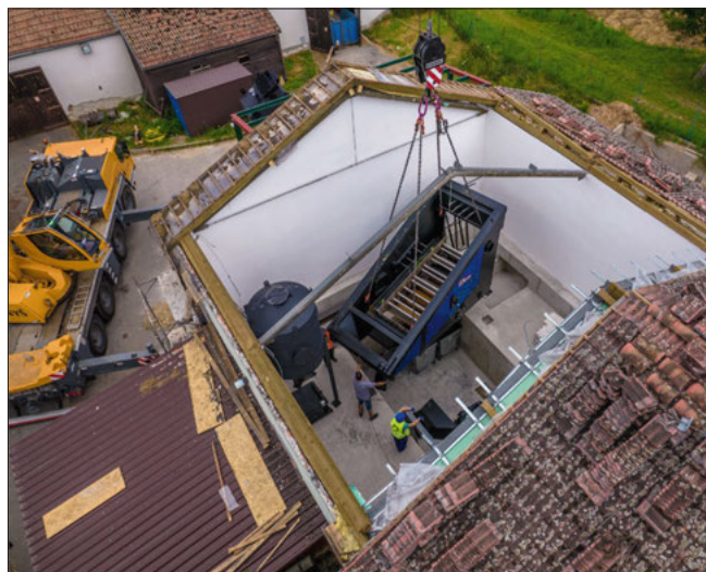
▼ Obr. 2 ● Kotelna na biomasu, instalace nového biokotle
