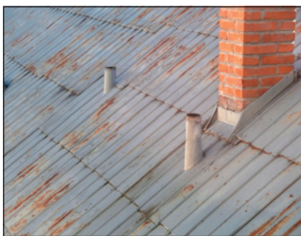
▲ Obr. 16 ● Příliš krátké větrací potrubí
