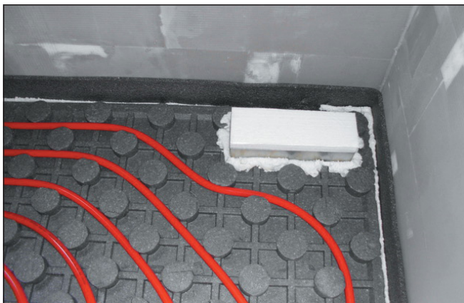
▼ Obr. 5 ● Osazení vyústky
