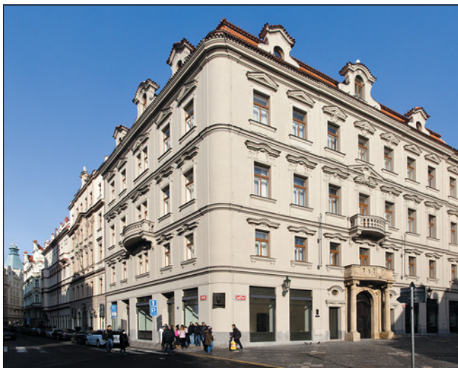
▲ Obr. 1 ● Secesní Kafkův dům v Praze v blízkosti Staroměstského náměstí po rekonstrukci
