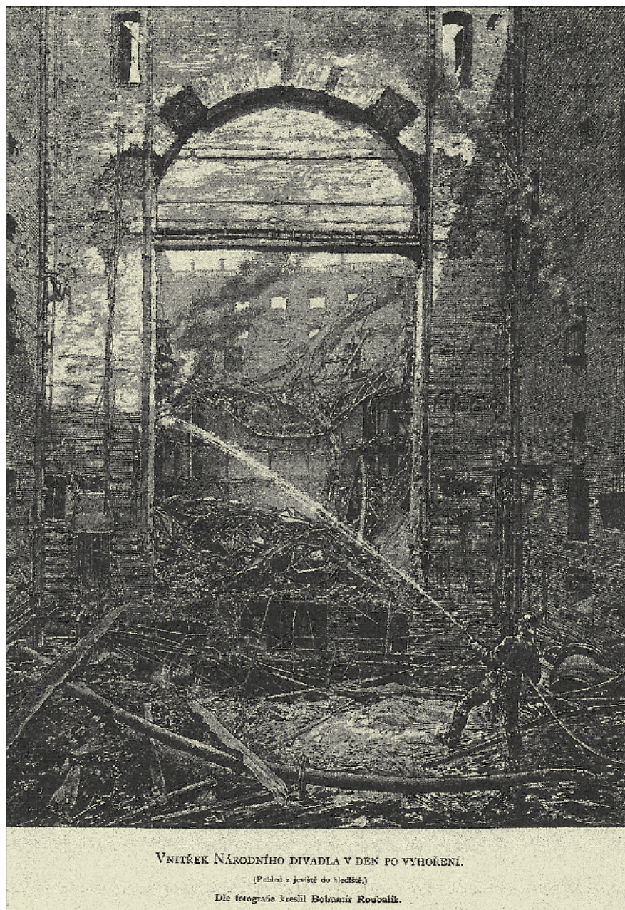
▼ Obr. 1 ● Vnitřní prostory ND v den po vyhoření [3]
