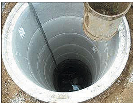
▼ Obr. 17 ● Kopaná studna ze skruží
