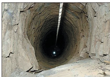
▲ Obr. 16 ● Kopaná studna z kamene
