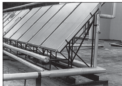
▲ Obr. 9 ● Venkovní tepelné izolace představovaly slabý článek – používala se skelná vata a místo drahého oplechování se obalovala vším možným, časté zatékání se pak řešilo argumentem: „sluníčko vše vysuší“
