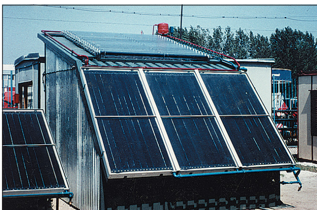
▲ Obr. 17 ● Ukázka sériového spojení plochých a trubkových kolektorů z důvodu zajištění vyšší výstupní teploty kapaliny, Agrokomples Nitra 1988 (k vidění občas i v dnešní době)
